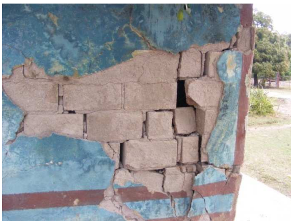
Figura 13. a – d. Destrucción de local de venta de productos y cafetería. Rotura de muros. Grietas escalonadas.
