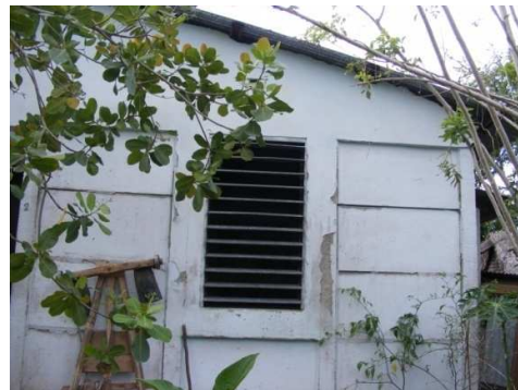
Figura 3 a - e. Rotura de las juntas de mortero entre paneles prefabricados
