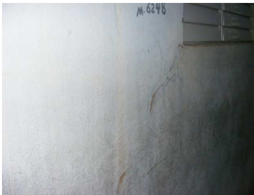
Figura 15. a – c. Grietas en esquinas de vanos.
