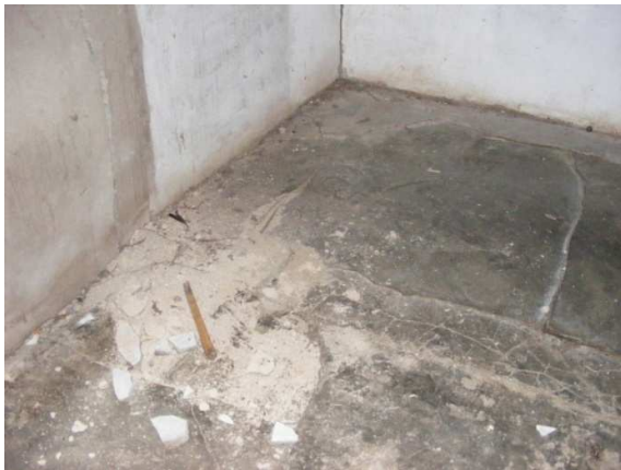
a) Figura 12. a – b. Hundimientos significativos del piso de mosaicos
