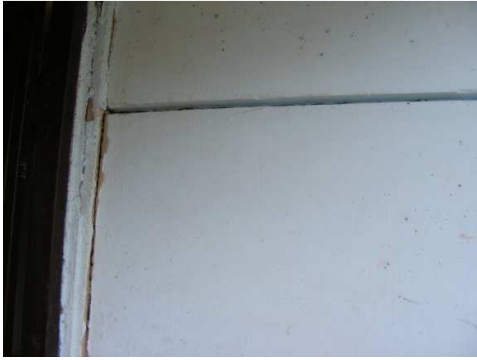
Figura 4. a – c. Algunas fisuras en el recubrimiento en pocas columnas prefabricadas del sistema Sandino.
