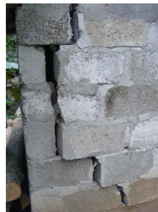
Figura 14. a – b. Grietas escalonadas en muros de bloques. Rotura de unión entre estos elementos.
