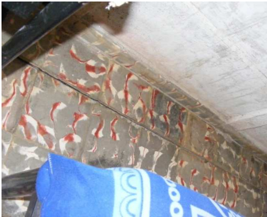
Figura 9. a – b. Hundimiento significativo de pisos.
