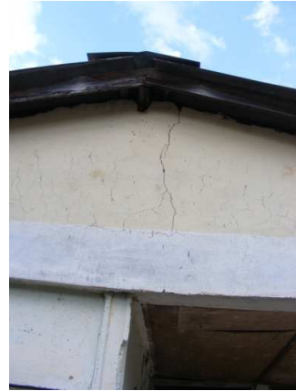
Figura 5. a – f. Grietas pasantes en varias direcciones en muros de mampostería.
