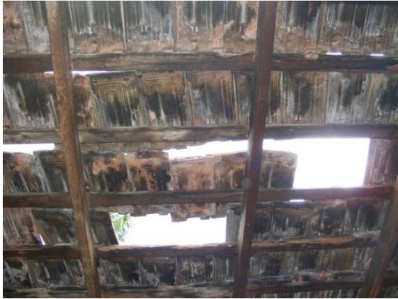
Figura 8. a – b. Caída de tejas francesas de barro de la cubierta
