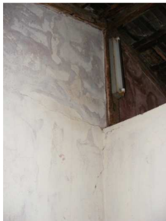
Figura 6. a – b. Grietas pasantes en uniones entre muros
