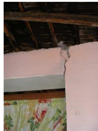
Figura 7. a – b. Grietas entre dinteles de hormigón y muros de mampostería
