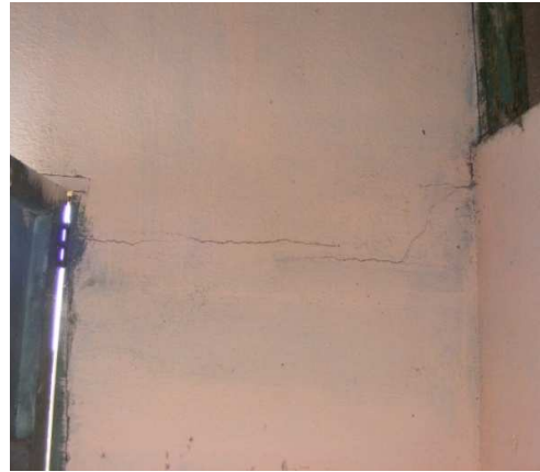
Figura 4. a – c. Algunas fisuras en el recubrimiento en pocas columnas prefabricadas del sistema Sandino.
