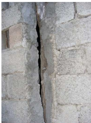
Figura 14. a – b. Grietas escalonadas en muros de bloques. Rotura de unión entre estos elementos.
