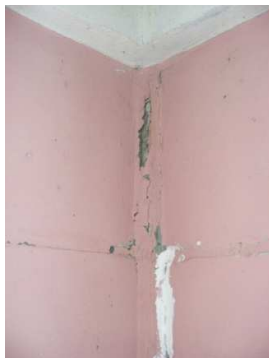
Figura 3 a - e. Rotura de las juntas de mortero entre paneles prefabricados
