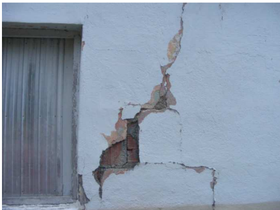
Figura 15. a – c. Grietas en esquinas de vanos.
