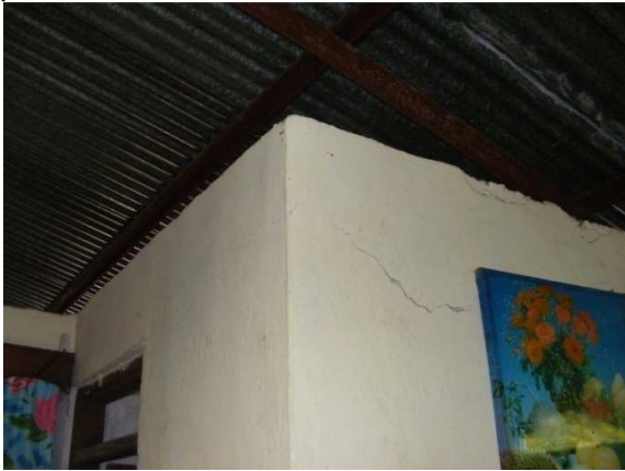
Figura 4. a – c. Algunas fisuras en el recubrimiento en pocas columnas prefabricadas del sistema Sandino.
