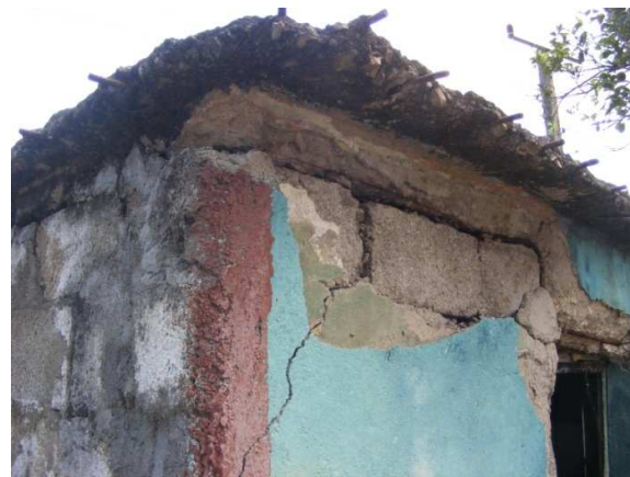
Figura 13. a – d. Destrucción de local de venta de productos y cafetería. Rotura de muros. Grietas escalonadas.
