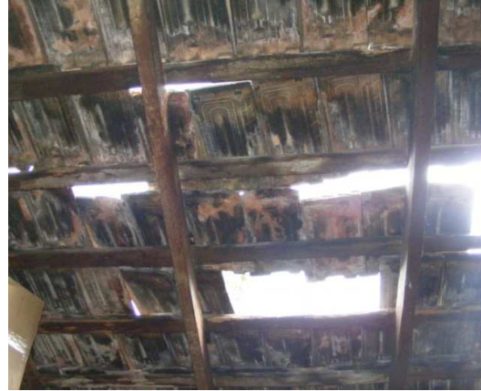
Figura 8. a – b. Caída de tejas francesas de barro de la cubierta
