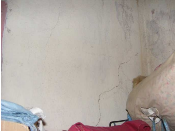
Figura 5. a – f. Grietas pasantes en varias direcciones en muros de mampostería.
